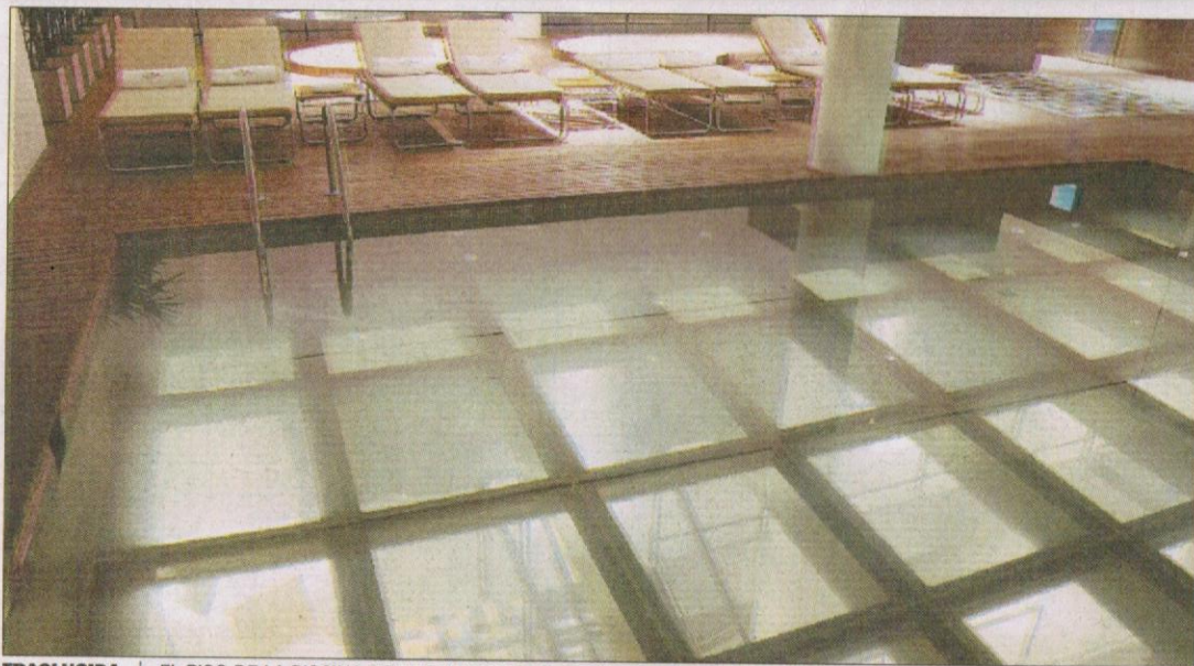
TRASLUCIDA | EL PISO DE LA PISCINA DEL WELLNESS ES EL TECHO DE AREAS PUBLICAS.
